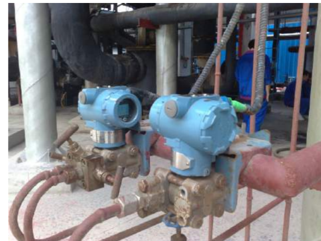
温压补偿涡街流量计安装现场
